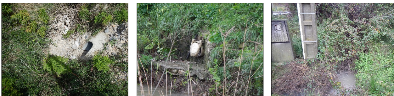
Rejets au milieu naturel des postes de relèvement : amont STEP village, ancienne STEP, Poissonnier
