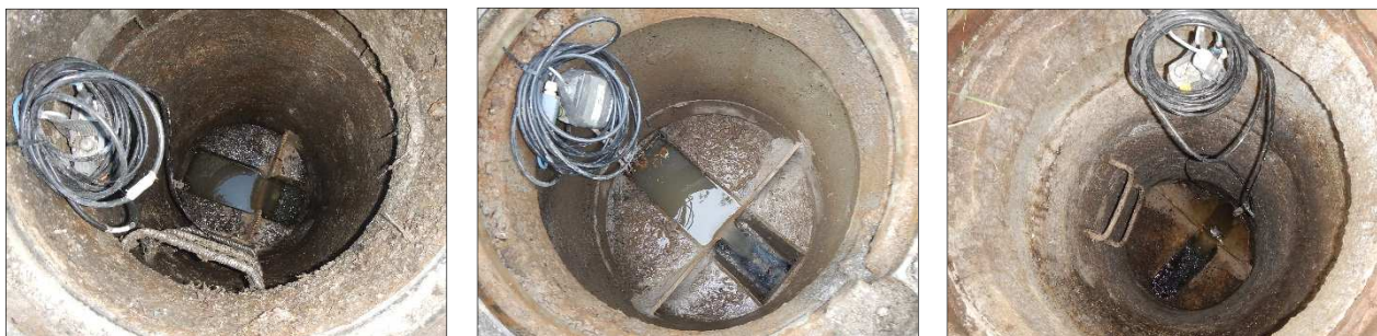
Exemples de points de mesure sur le système d'assainissement de Calvisson
