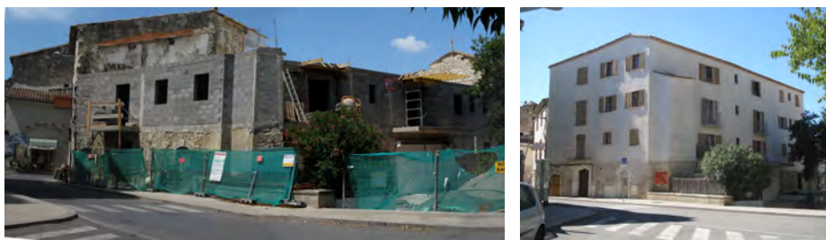
Maison du Peuple pendant et après travaux
